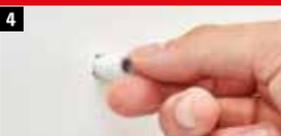
Mit Drehbewegung den umgelegten Dübel oberflächenbündig in die Wand drücken.
