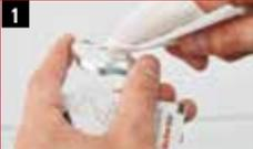
Mit dem Reinigungstuch Fliese und Adapterplatte reinigen.
