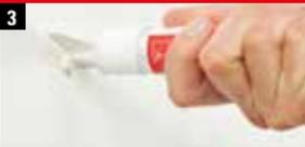
Spachtelmasse an gewünschte Stelle drücken, dabei das Bohrloch etwas überfüllen.
