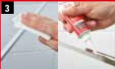
3 Oberflächen reinigen. DICHTKLEBER auf Glasprofil auftragen.
