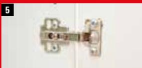
5 Schrauben direkt im Anschluss in die Reparaturmasse drehen.
