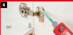
4 Gegebenenfalls durch das Schraubenloch des Scharniers noch mal nachfüllen.
