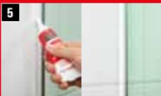
5 Abfugen des Glasprofils mit der Fliesenwand.
