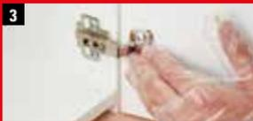
3 Scharnier innerhalb von 30 Sekunden in die ausgebrochene und bereits aufgefüllte Stelle eindrücken.
