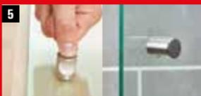
5 Metallgriff auf die Glastür drücken. Nach 10 Minuten ist die Verklebung handfest, nach 1 Stunde funktionsfest. Nach 24 Stunden ist die Verklebung endfest.
