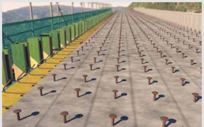
Beton-Beton Schubverbinder zur Verstärkung
