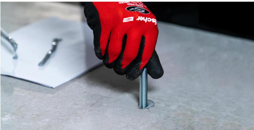
Bei Injektionssystemen werden Ankerstangen ganz einfach von Hand mit einer leichten Drehbewegung in das mörtelgefüllte Bohrloch eingesteckt.
