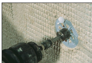
Montáž upevnění skrz zpevňovací skleněnou síťovinu
