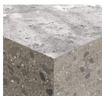
Tlačenou zónu betonu
